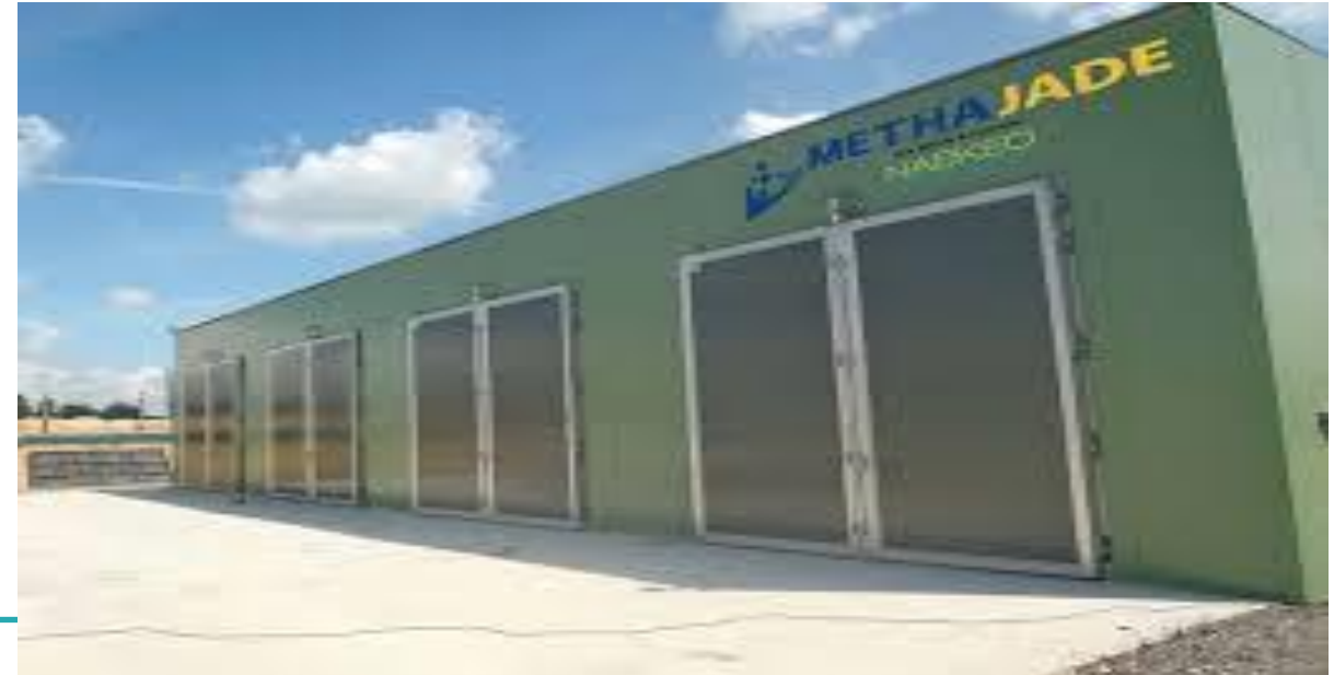
« En garage »/ voie sèche
